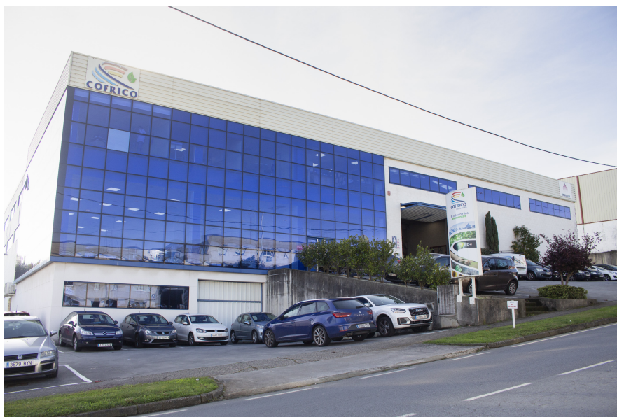
Figura 1.1: Sede central de Cofrico en Bergondo.
